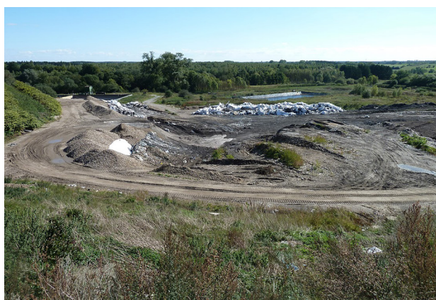
Figure 3. Casier n° 2 en cours de remplissage (Habay, 27 septembre 2015).
